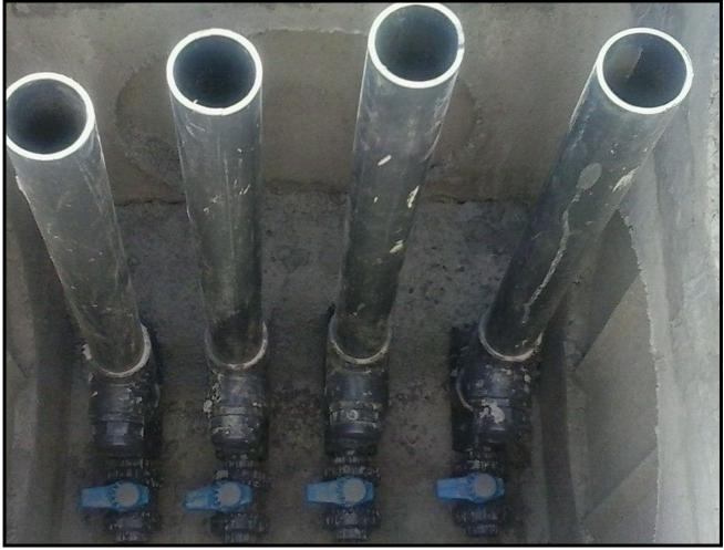
Uscite a tenuta stagna multiple con valvole e tubi di carico (Guida Battenti)
